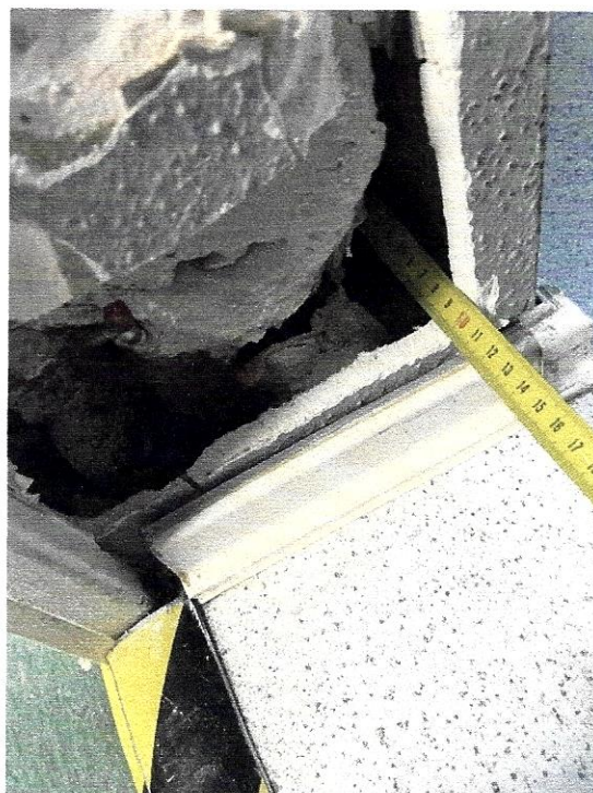
fot. 3. Próg o wysokości 8 cm przy istniejących drzwiach wejściowych do pomieszczenia nr 22
