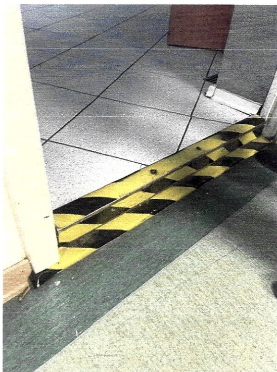
fot. 3. Próg o wysokości 8 cm przy istniejących drzwiach wejściowych do pomieszczenia nr 22
