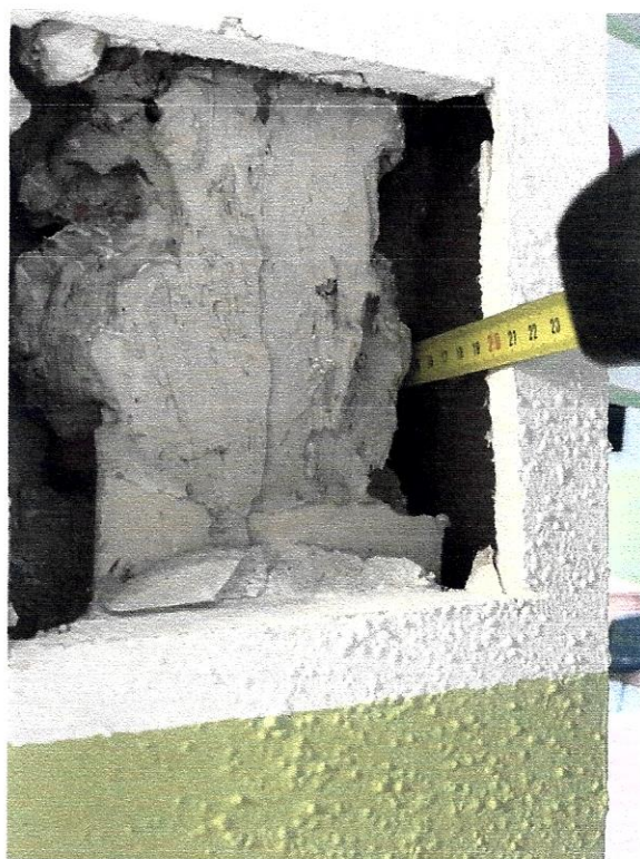
fot. 5. Odkrywka przy ościeżnicy drzwiowej przy suficie
