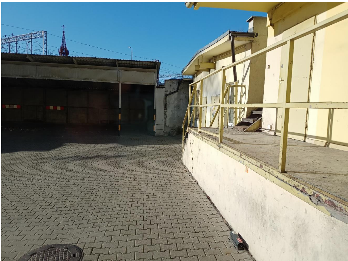
FOT. 2. TYŁ BUDYNKU (TEREN WEWNĘTRZNY)
