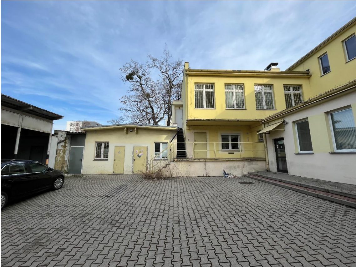
FOT. 3. TYŁ BUDYNKU (TEREN WEWNĘTRZNY)
