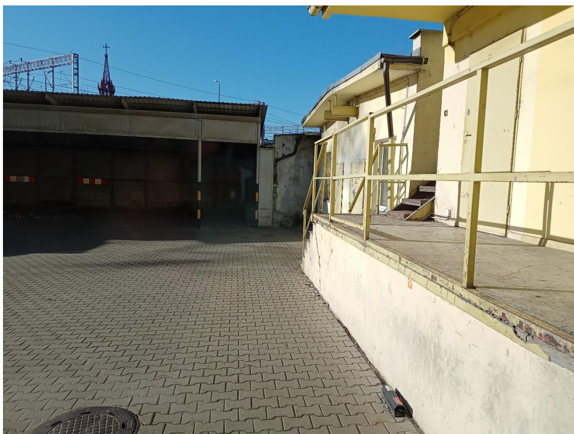
FOT. 2. TYŁ BUDYNKU (TEREN WEWNĘTRZNY)
