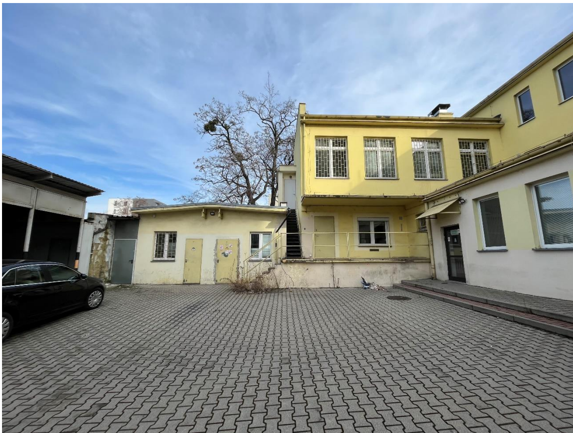
FOT. 3. TYŁ BUDYNKU (TEREN WEWNĘTRZNY)
