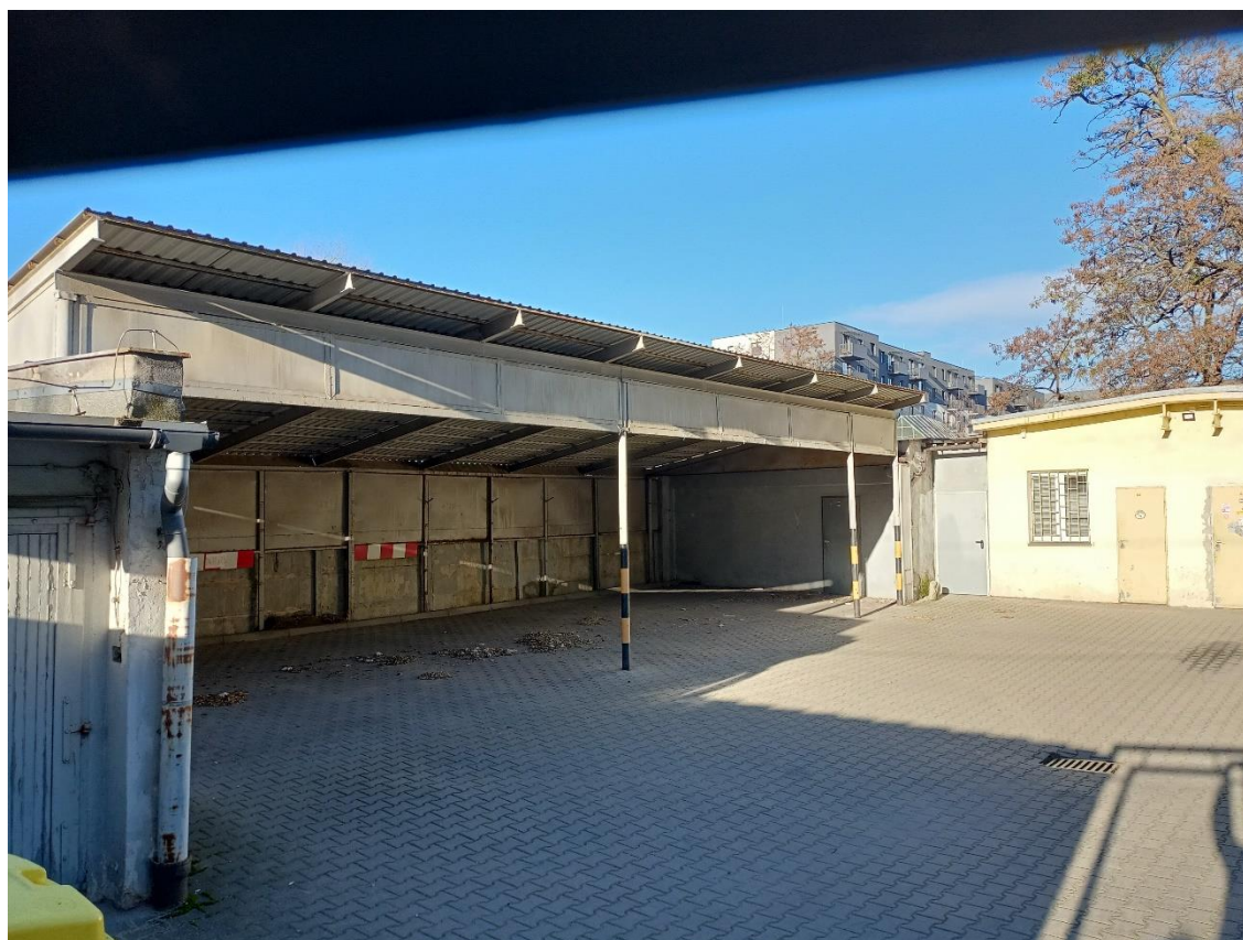
FOT. 4. WIATA (TEREN WEWNĘTRZNY) – MIEJSCE MONTAŻU STOJAKÓW NA ROWERY
