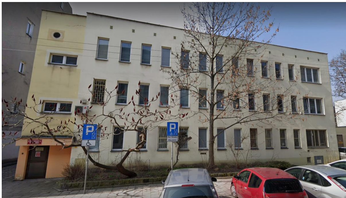
FOT. 1. FRONT BUDYNKU
